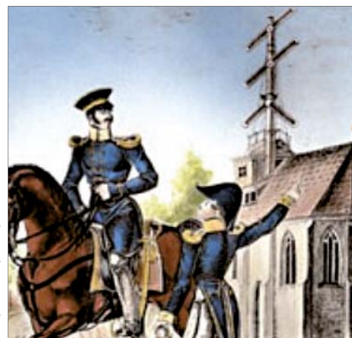
Fot. 2. Wieża przekaźnikowa na trasie Berlin – Koblence; wyraźnie widać sześć belek sygnalizacyjnych wg [1]
