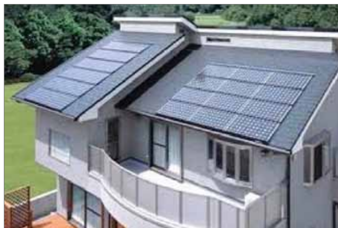
Rys. 1. Dom jednorodzinny z zainstalowanymi panelami fotowoltaicznymi [5]
