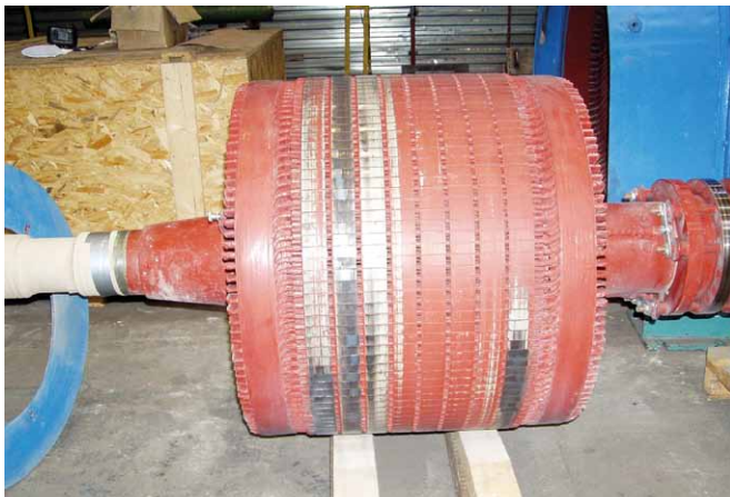
Rys. 7. Zatarty wirnik silnika SYUe-148r/01 1000 kW 6 kV
