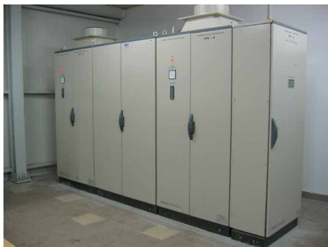
Rys. 1. Zestaw sterujący maszyną jednosilnikową wyciągową o mocy 2000 kW
