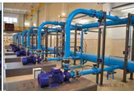
Rys. 3. Widok układu pompowego Przepompowni „Telefoniczna”
