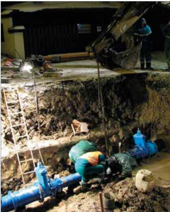
Rys. 3. Zabudowa przepływomierza dla OOS-u
