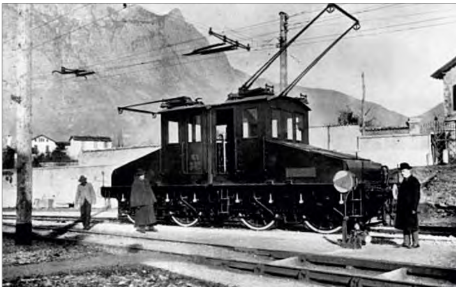
Fot. 2. Pierwsza na świecie lokomotywa 3X3600 V AC, 15 Hz zaprojektowana przez Kálmána Kandó i zbudowana w firmie Ganz elektryfikowała kolej Valtellina we Włoszech
