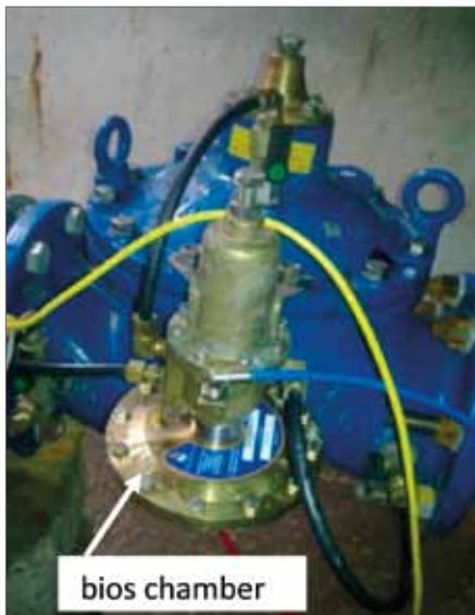
Rys. 5. Montaż – sterownik pneumatyczny
