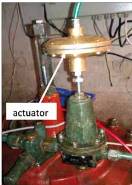
Rys. 6. Montaż – sterownik hydrauliczny
