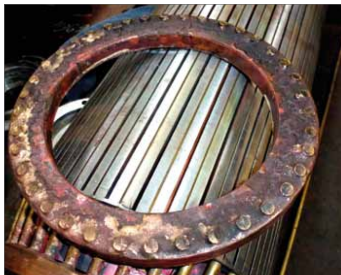
Rys. 7. Widok pierścienia zwierającego po stronie przeciwnapędowej i strefy zerwania prętów klatki rozruchowej
