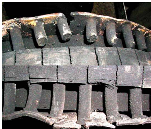
Rys. 19. Zerwane pręty i pęknięte pierścienie
