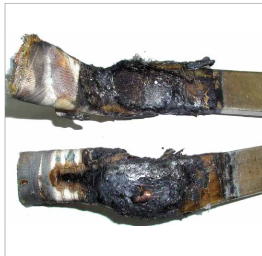
Rys. 15. Skutki wytarcia izolacji głównej
