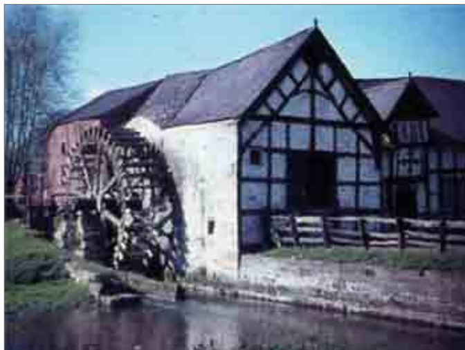
Fot. 1. Pierwsza niekomercyjna elektrownia wodna na świecie w Grand Rapids wg [2]
