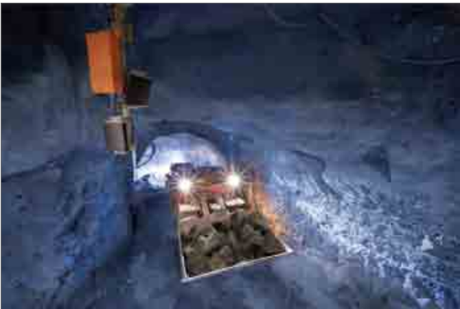
Rys. 3. Ładowarka pracująca w systemie telesterowania. Widoczny zespół anten nadawczo-odbiorczych [17]
