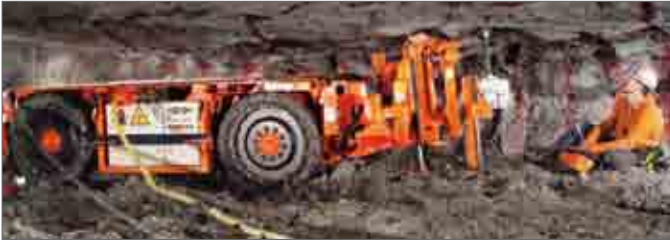
Rys. 1. Sterowanie operacją kotwienia stropu [18]
