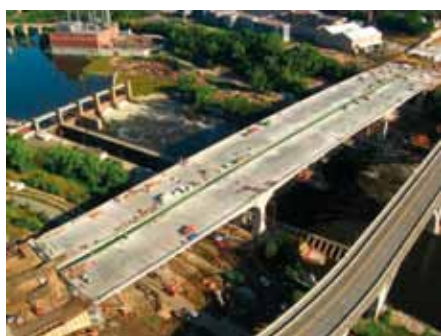
Rys. 4. Nowo budowany most I35W w Minneapolis [3]
