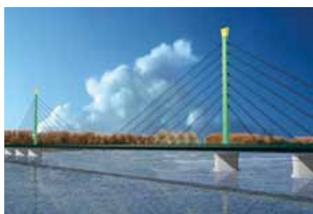
Rys. 7. Nowo zbudowany most podwieszany nad Wisłą [4]
