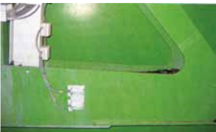
Rys. 11. Miernik naprężeń zastosowany w konstrukcji pasa dolnego wysięgnika koła czerpakowego. Powyżej widoczny czujnik wykorzystywany w układzie rejestracji naprężeń [8]
